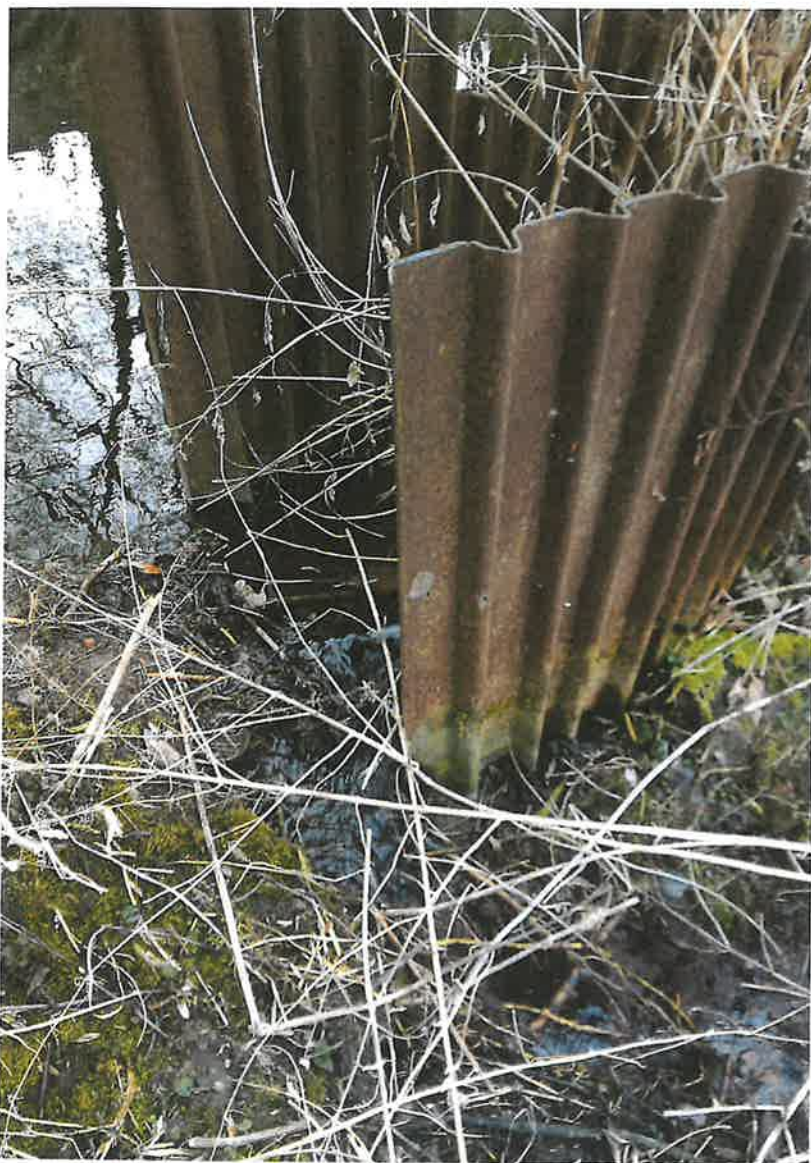
Obr. 2: Provizorní zabezpečení Union pažnicemi - průsaky
